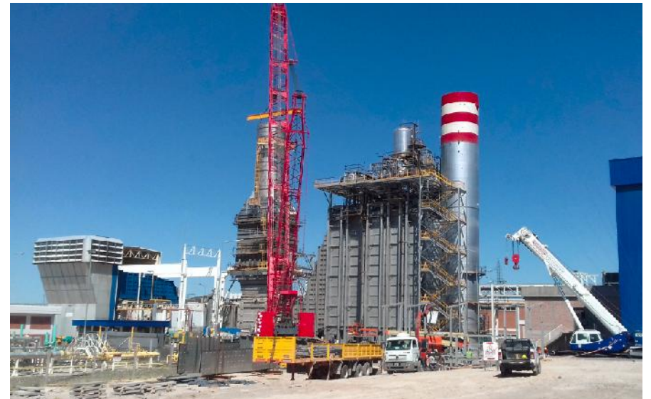
09/02/18 – Montaje HRSG
